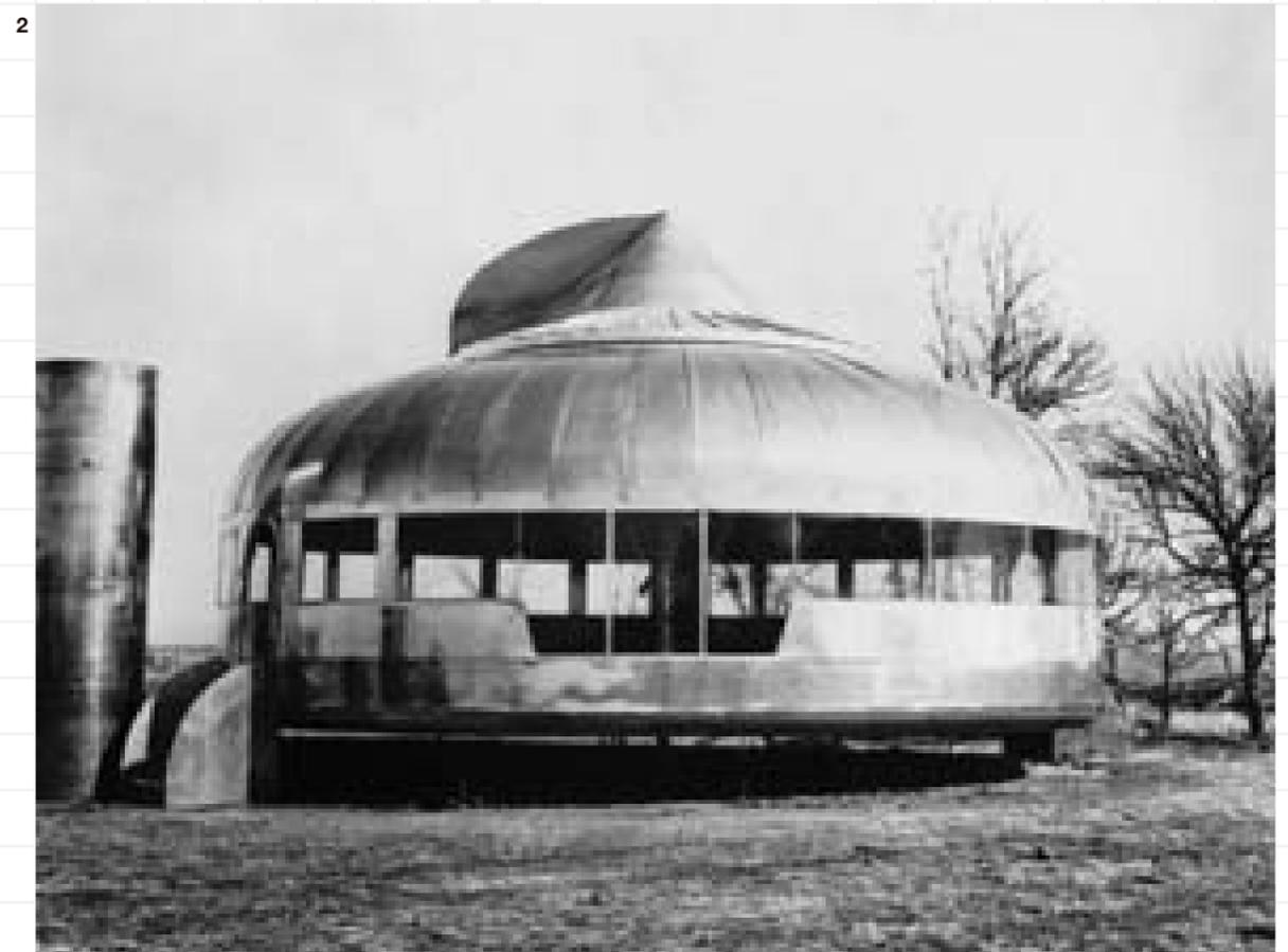
**3 Das «Dymaxion-Fertighaus» von Buckminster Fuller war ein rundes Einfamilienhaus, das von einem zentralen Mast gestützt wurde, aus über 3'000 Aluminiumteilen bestand und in einer Metallröhre verschickt werden konnte. Nur zwei Prototypen wurden gebaut.**
